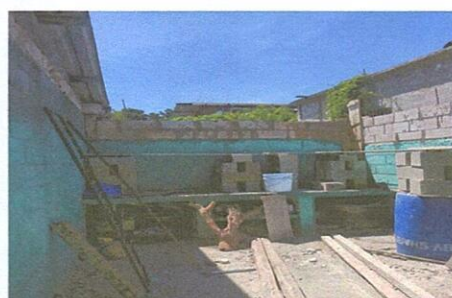
Foto 2: Levantamiento de pared de la cocina del establecimiento
