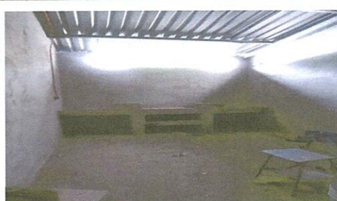
Foto 4: Repello y techado del Interior de la cocina
